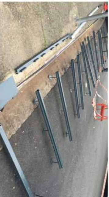
1 Posicionamento e nivelamento das longarinas.
