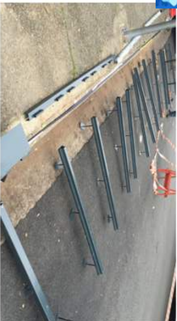
1 Posicionamento e nivelamento das longarinas.
