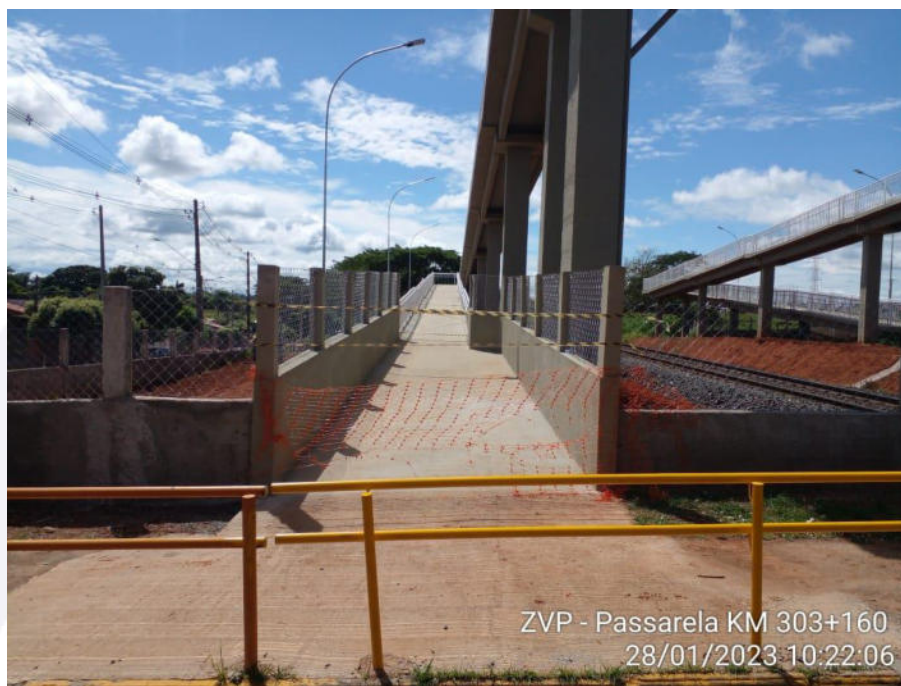
Imagem 5 – Passarela de Pedestres
