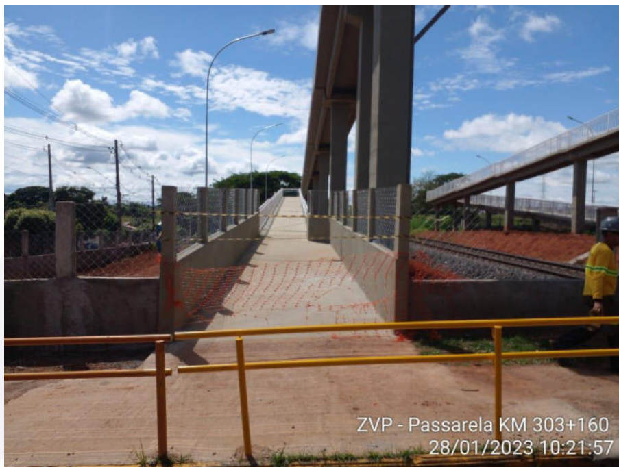
Imagem 3 – Passarela de Pedestres
