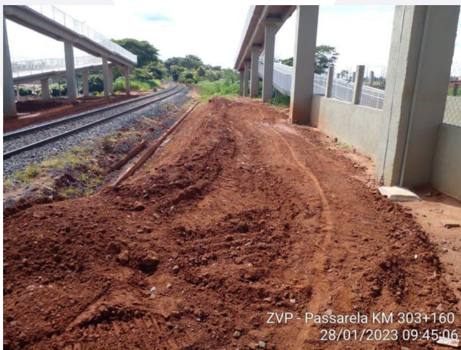
Imagem 8 – Passarela de Pedestres
