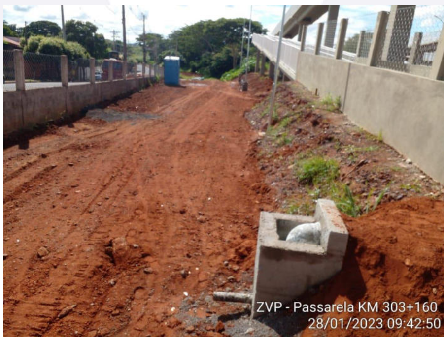
Imagem 10 – Passarela de Pedestres
