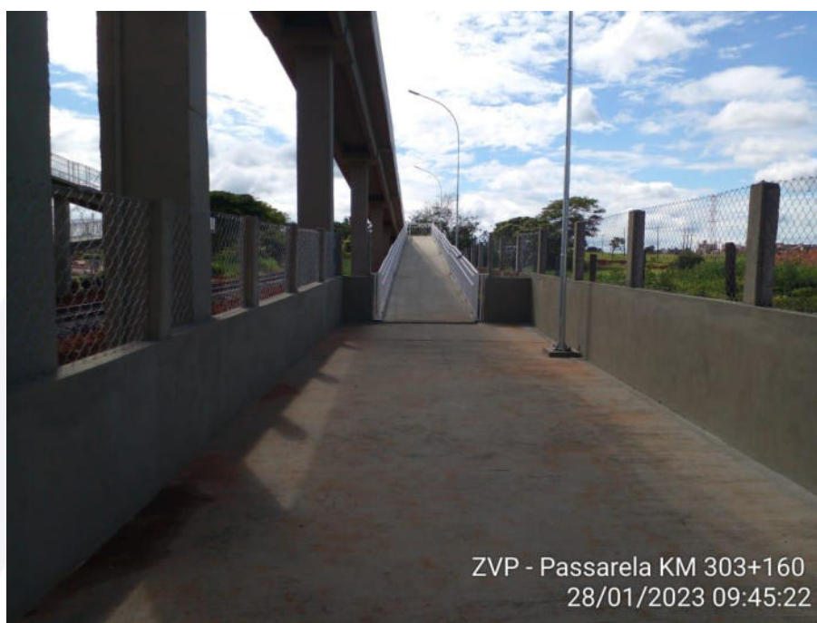
Imagem 7 – Passarela de Pedestres
